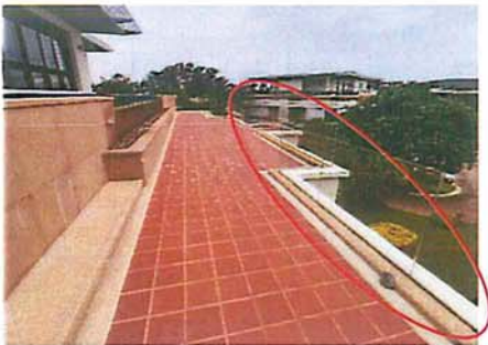
กระจากเดิมยึดด้วยซิลิโคน ไม่มีเฟรมยึด
