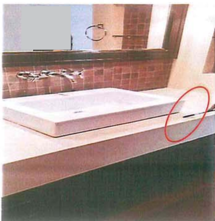
รอยร้าวบริเวณTOP หิน เคาะที่เตอร์อ่างล้างหน้า
