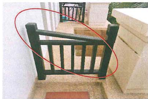
ลูกกรงไม้หลุด
