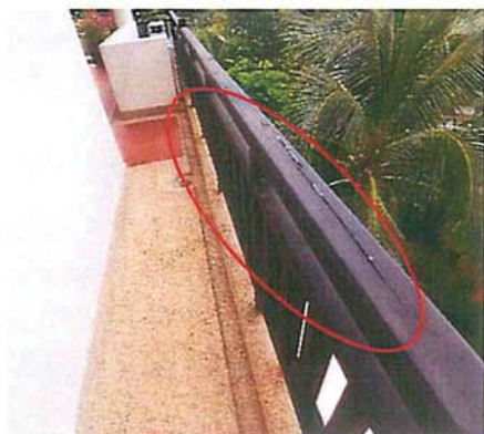
งาน ลูกกรงไม้ มีรอยแตกหักชำรุด
