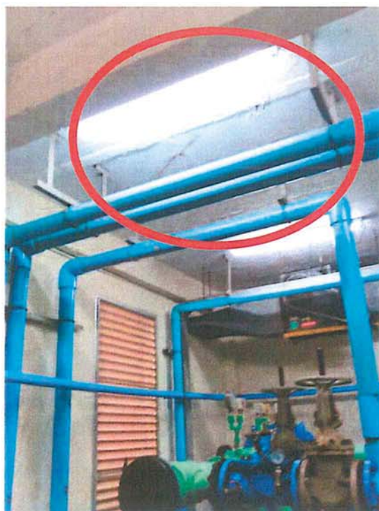
รูปภาพการสำรวจอาคารสำนักงาน ห้องเครื่อง ส่วนใหญ่เกิดรอยร้าวและมีรอยร้าวจากด้านบน หลังคาห้องเครื่องซึ่งเป็นพื้นคอนกรีต
