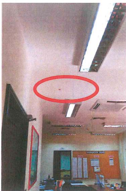
รูปภาพการสำรวจอาคารสำนักงาน ห้องเครื่อง ส่วนใหญ่เกิดรอยร้าวและมีรอยร้าวจากด้านบน หลังคาห้องเครื่องซึ่งเป็นชั้นดาดฟ้า
