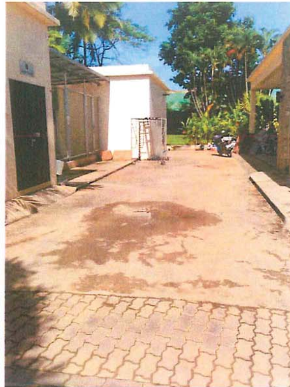
บริเวณที่ตั้งหม้อแปลงไฟฟ้า มีรอยร้าวตามรูป พื้นทรุดตามสภาพใช้งาน ๙
