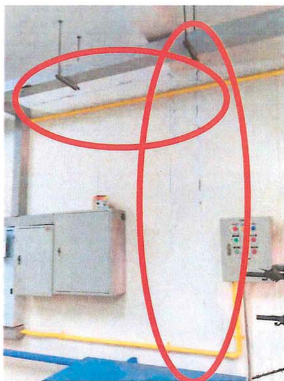
รูปภาพการสำรวจอาคารสำนักงาน ห้องเครื่อง ส่วนใหญ่เกิดรอยร้าวและมีรอยร้าวจากด้านบน หลังคาห้องเครื่องซึ่งเป็นพื้นคอนกรีต
